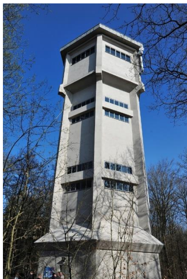
Figure 52 : Château d'eau de Reimberg (Photo : Visit Guttland)
