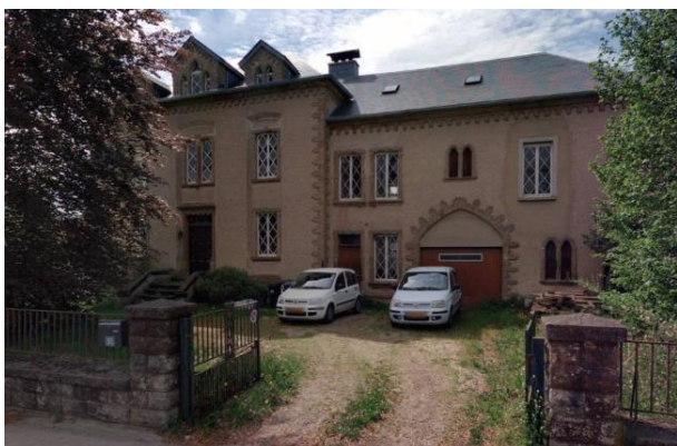
Figure 79 : Maison classée à Bettborn (Source : Cyclomedia Street Smart)
