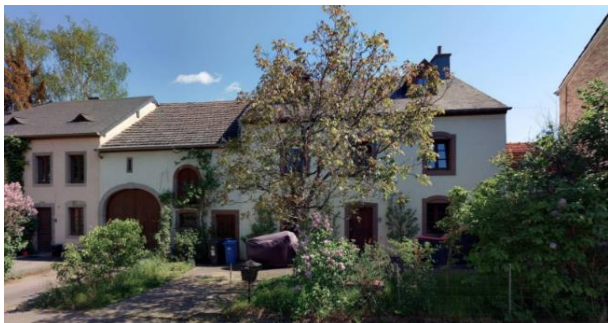
Figure 77 : Ferme classée à Vichten (Source : Cyclomedia Street Smart)
