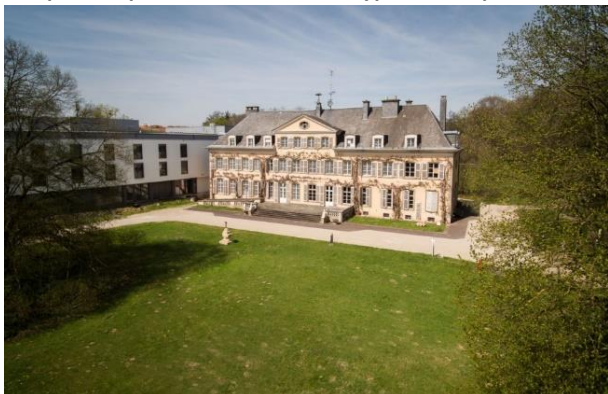
Figure 75 : Château de Colpach (Source : Commune d'Eil)
