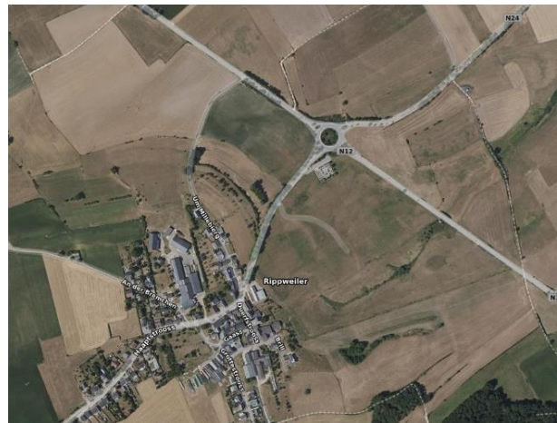
Figure 102 : Vue aérienne de la décharge de déchets inertes Brill à Rippweiler en 2022 (Source : geoportail.lu)
