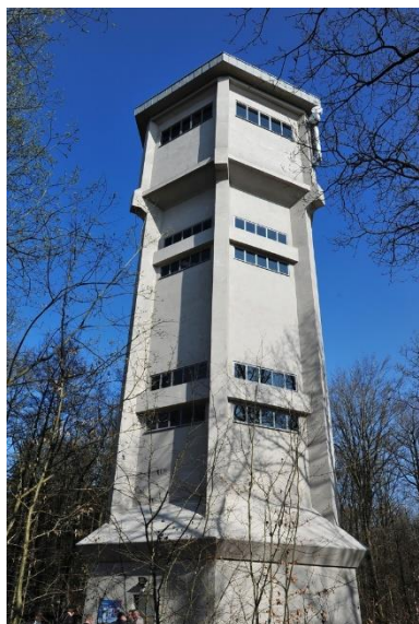
Figure 52 : Château d'eau de Reimberg (Photo : Visit Guttland)
